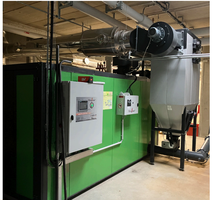
Implantation d'une chaufferie bois (SICECO - CÔTE-D'OR CHALEUR)
