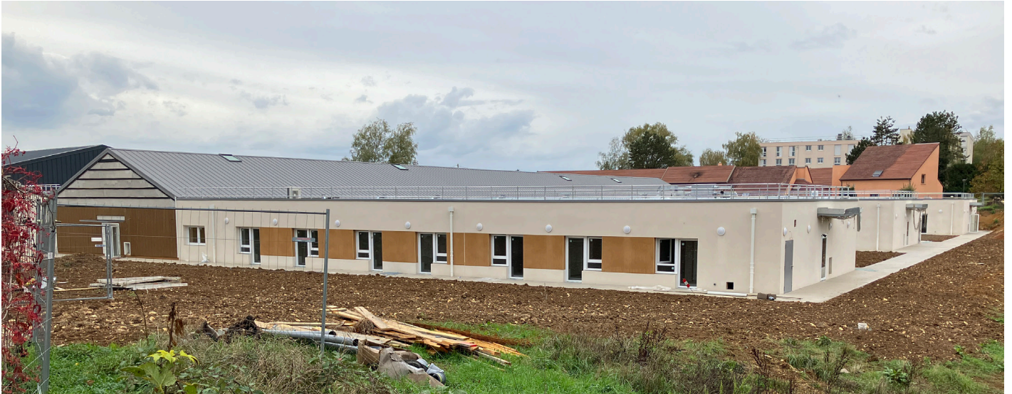
Construction en cours par ORVITIS du nouvel Etablissement d'Accueil Médicalisé Ste-Elisabeth
