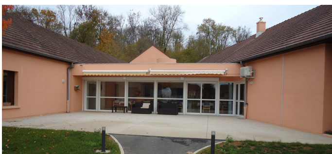
Rénovation de la Maison d'Accueil pour Personnes Agées.
